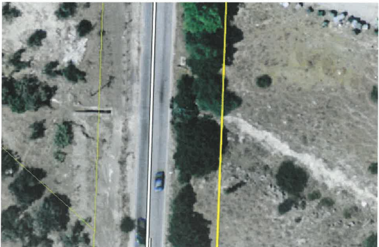
ΣΤ.39. Τεχνικό έργο ρέματος από αεροφωτογραφία έτους 2007-2009 πριν την διαπλάτωση της επαρχιακής οδού δυτικά αυτής (Πηγή Ελληνικό Κτηματολόγιο)
