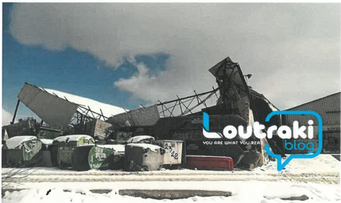
ΣΤ.24. Φωτογραφία που φαίνεται το κτίριο που έχει καταρρεύσει και οι κάδοι των απορριμμάτων (Πηγή: διαδικτυακή ιστοσελίδα)
