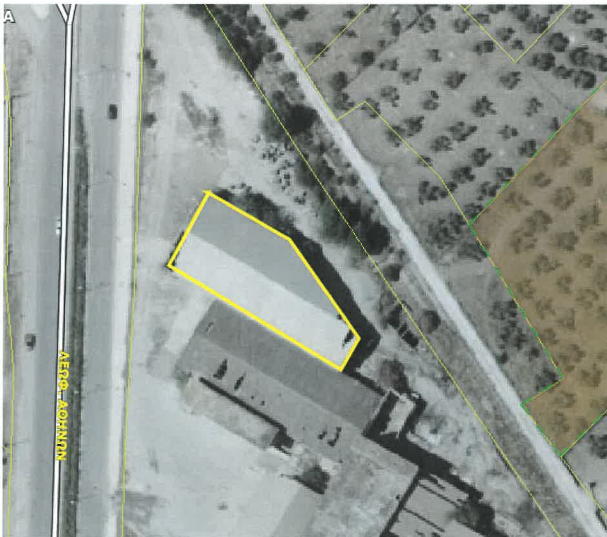
ΣΤ.22. Απόσπασμα αεροφωτογραφίας έτους 2015-2016 όπου με κίτρινη γραμμή σημειώνεται το κτίσμα που κατέρρευσε με την χιονόπτωση (Πηγή Ελληνικό Κτηματολόγιο)
